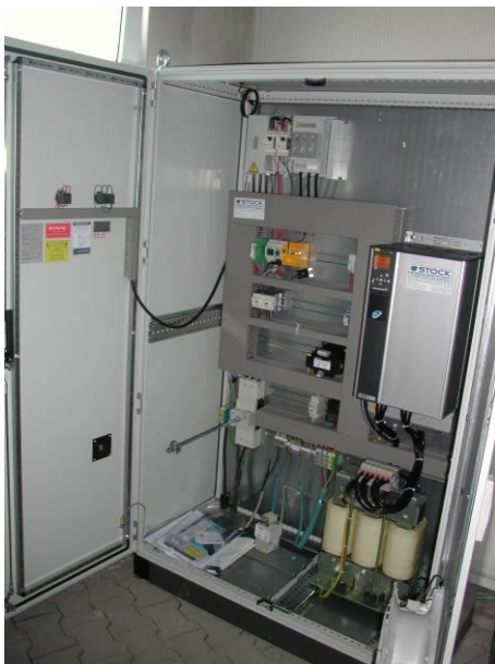
Abbildung 21: Frequenzsteuerung der neuen Pumpe.
