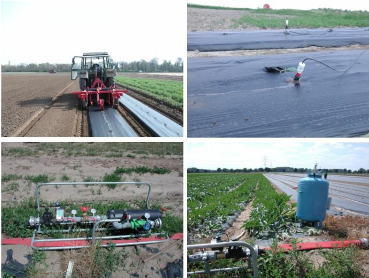
Abbildung 26: Verlegung des Tropfsystems, neue Kopfstation und Düngefass.
