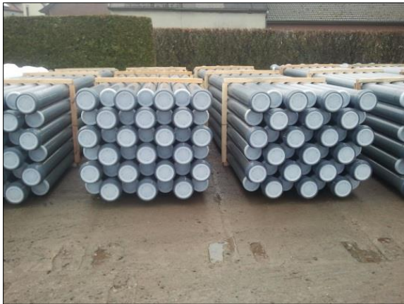
Abbildung 14: PVC-Rohre der Erdleitung vor dem Einbau
