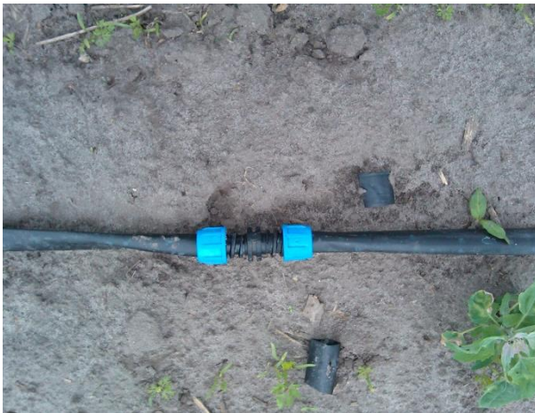
Abbildung 4: Reparaturstelle eines Tropfschlauches nach Beschädigung durch Wildtiere
