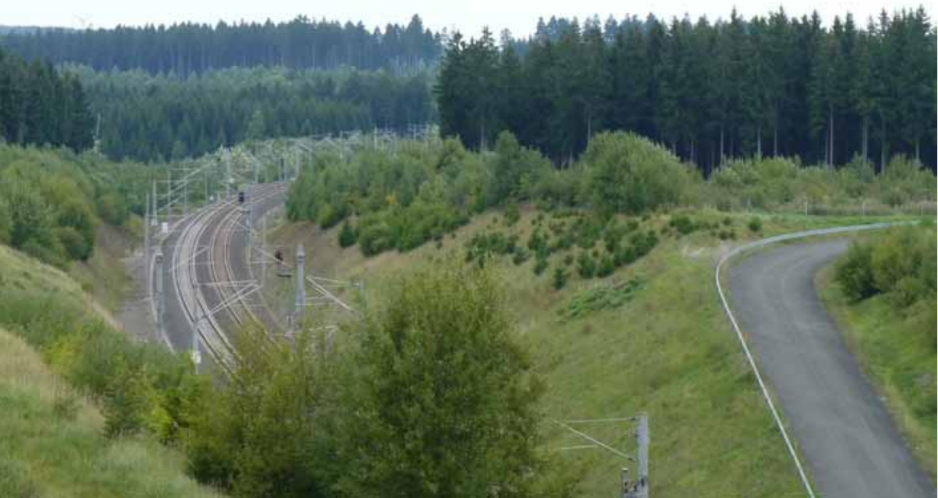
Abbildung 7: Verinselung von Waldflächen durch Verkehrsinfrastruktur
